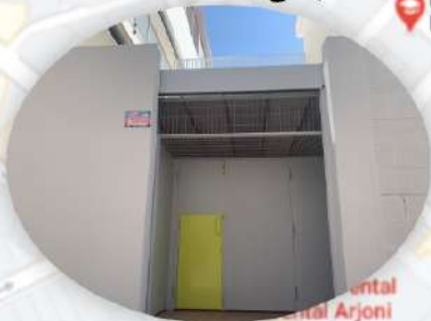
PUERTA A (Calle Santo Domingo)
